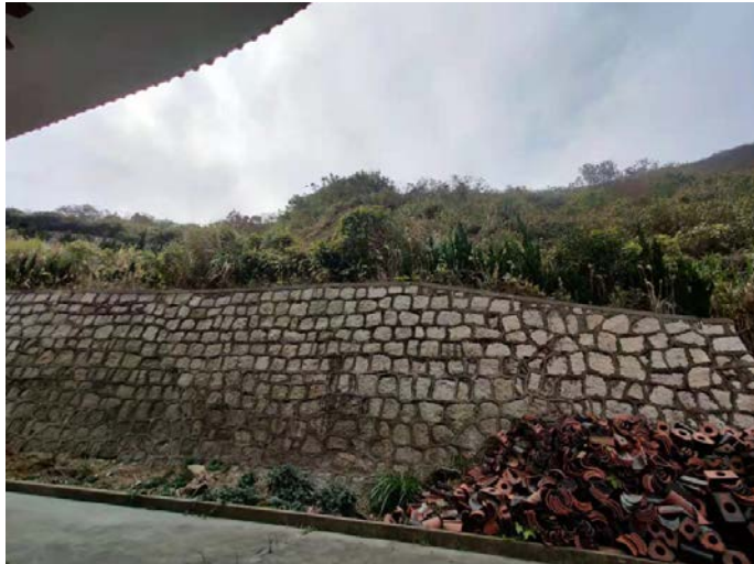
厂界西侧实景图
